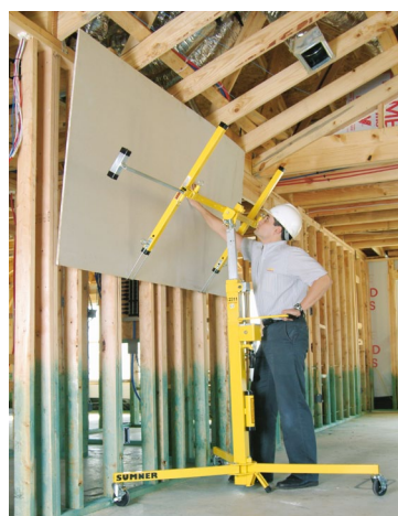
Inclinação de 65° para colocação de placas em parede
