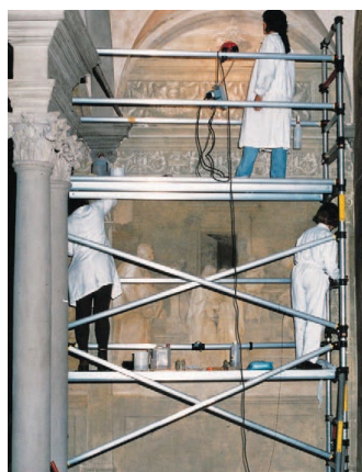
Obras de restauro
