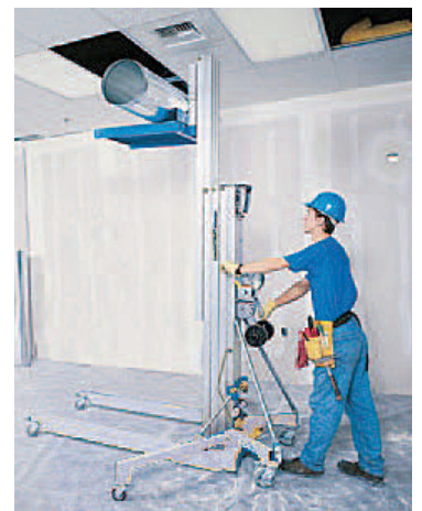
Colocação de tubos em tetos falsos
