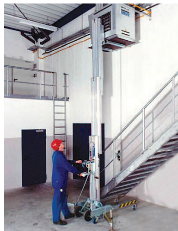
Colocação de aparelhos AVAC
