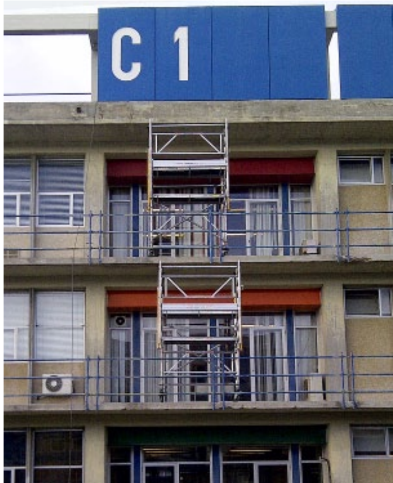
Trabalhos de manutenção em edifício habitacional
