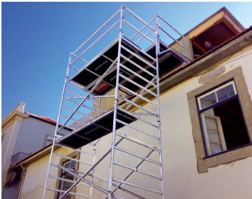
Consola em trabalhos no telhado
