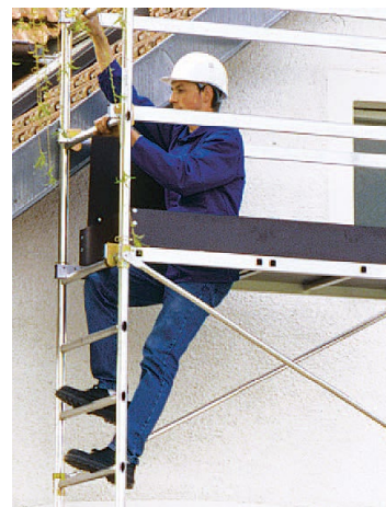
Passagem através de plataforma
